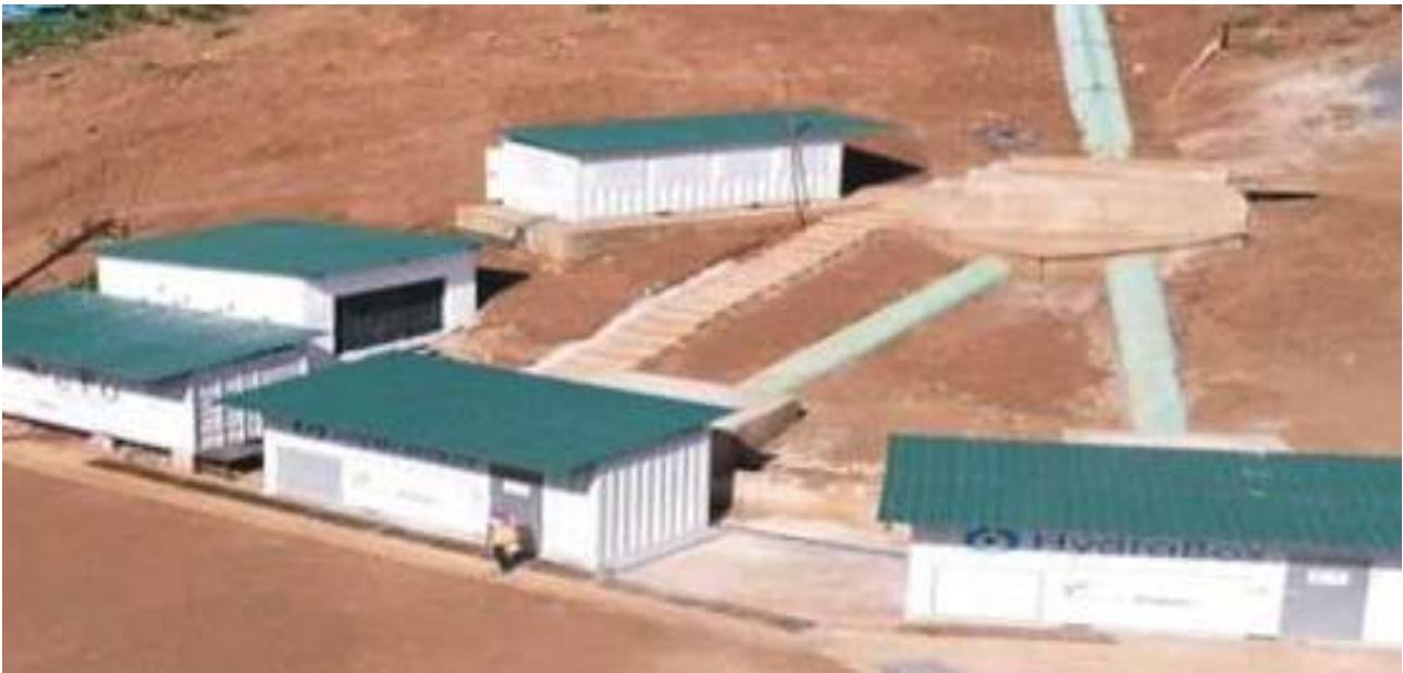
Gitugi Mini Hydro-Power Station
